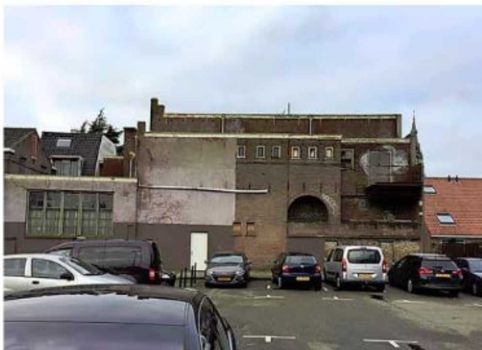
De Gasthuisplaats, thans in gebruik als parkeerplaats.
